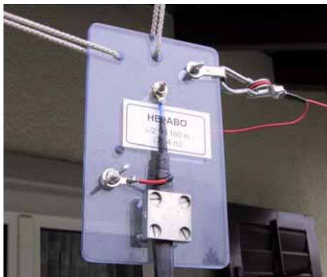
Bild 2 Verbindungsstück zwischen Antenne und Koaxtrafo, Seite Koaxkabel. Zugentlastung für Antenne und Kabel
